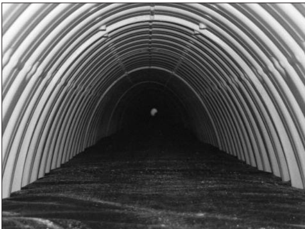
Vue de l'intérieur de la rangée Isolator, à partir du puits d'accès. On peut voir le géotextile tissé, installé entre la pierre et les chambres.
